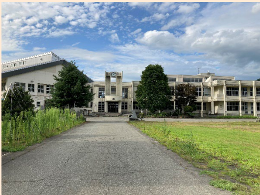
校舎等の外観写真
