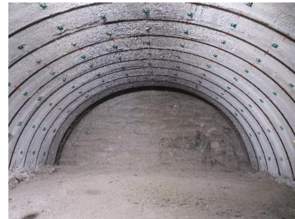
掘削中の岩盤
