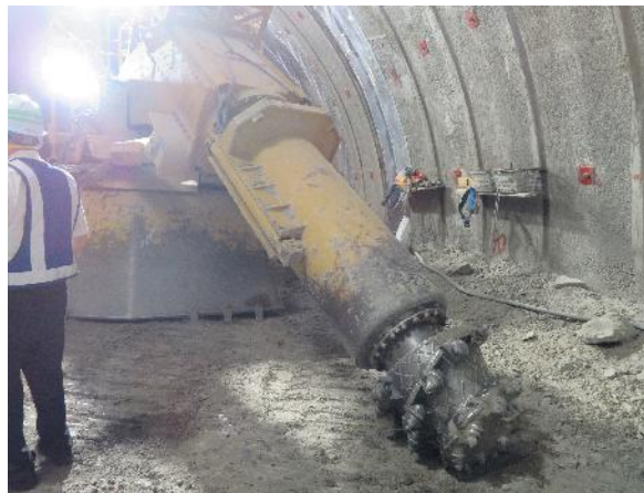
自由断面掘削機
