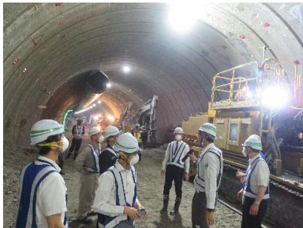
トンネル内の様子
