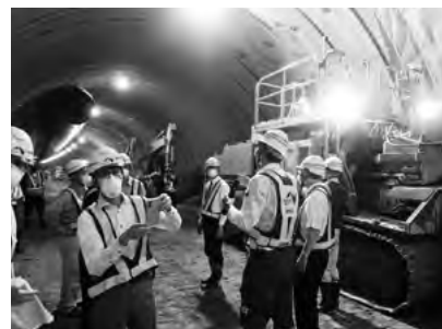
山内トンネル現場
