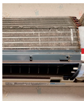
エアコンクリーニング前後
