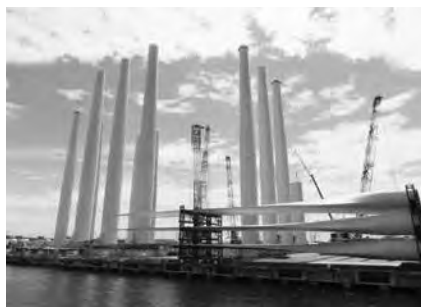
地耐力強化を行った飯島地区
