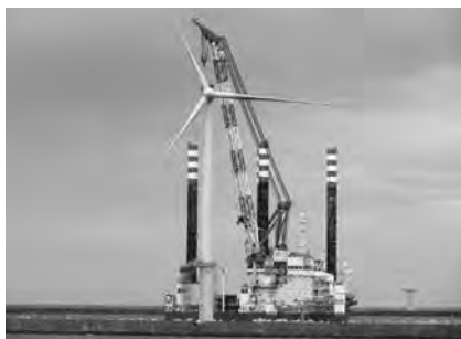
風車据付工事模様
