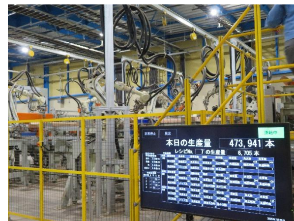
木の穴のパテ埋めはAIで管理し、補修ロボットで使用して省人化を図っている（写真：加工集成材棟）
