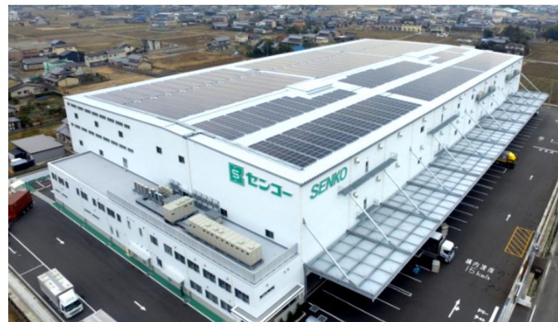
【工場屋根に太陽光パネル設置】 (岐阜県羽島市)
