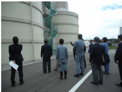
【メタン発酵槽】
