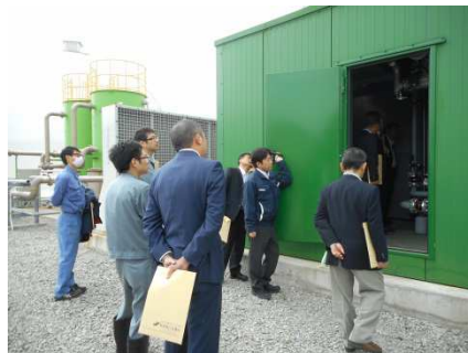
【ガス発電機室】
