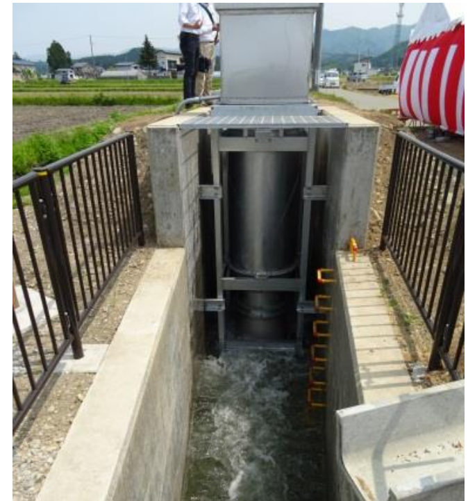
六郷東根小水力発電所（美郷町）（出力11kW）
