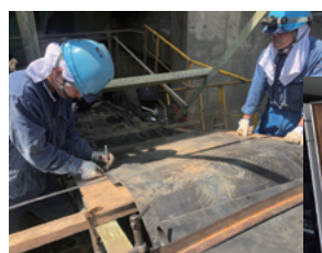
作業現場の風景
